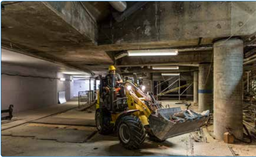
Der Radlader WL20e bei der Sanierung der Olympiaschwimmhalle in München.
