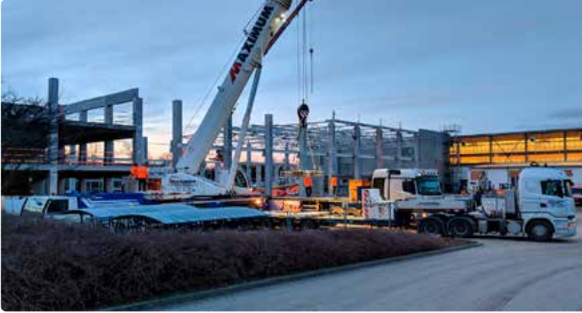
Hallenneubau bei Profiroll für die Werkzeugfertigung
