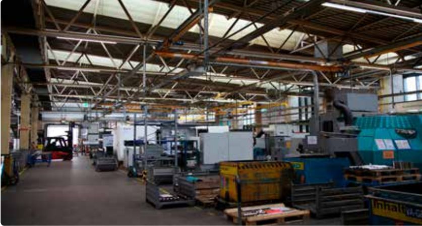
Vollautomatische Steuerung der Beleuchtung, bei Tag und Nacht
